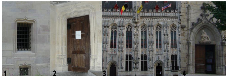
fig. 6: Portails bourguignons et néerlandais: 1 fenêtre du logis Philippe le Bon, Dijon, 2 porte dans la Tour Philippe le Bon, 3 façade de l'Hôtel de Ville à Bruges 4. portail sud de la façade occidentale de l'église Saint-Hippolyte de Poligny (photos de l'auteur; Toman & Beyer & Borngässer, Style gothique , p. 186.)
