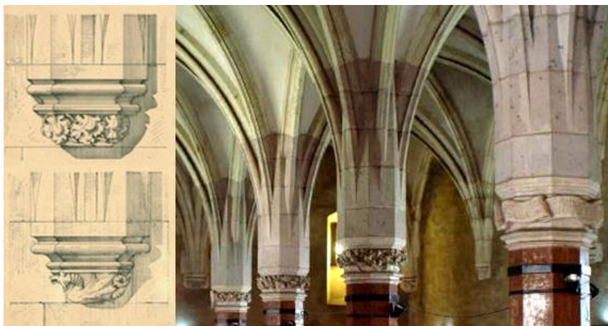
fig. 4: Naissances des voûtes de la salle des Chevalier du château des Corvin (Folio de Wiener Bauhütte aVI s2, sources : Département de l'Histoire d'Architecture et des Monuments, Collection des Plans et des Photos)
